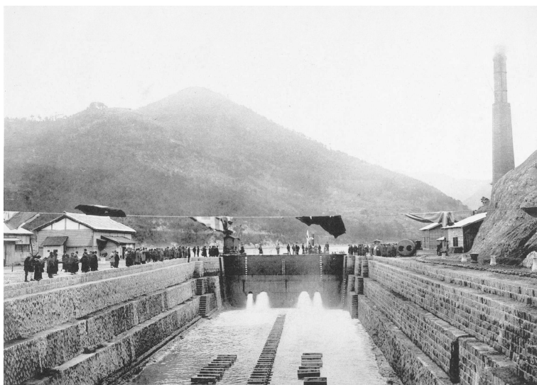
1912年、完成した播磨造船の船渠
