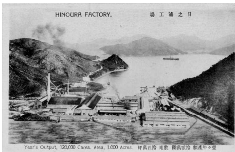
操業中の日の浦工場
